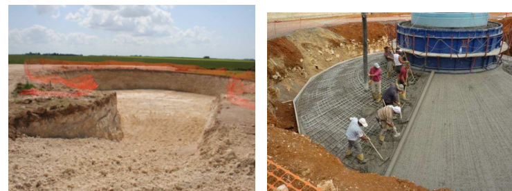
Figure 15 : Photographies d'un terrassement et d'une fondation d'éolienne
